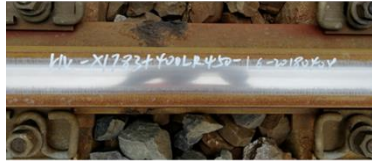
打磨后50Mt钢轨表面状态
