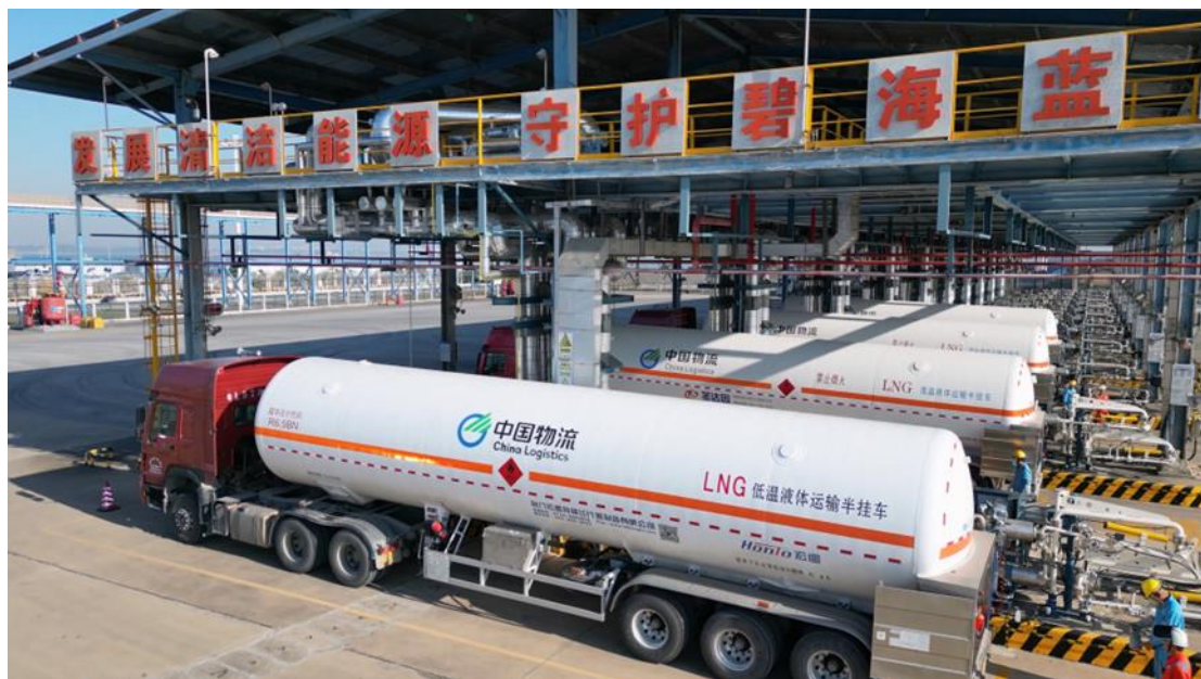
图 14：公司在广西北海接收站进行 LNG 装配作业
